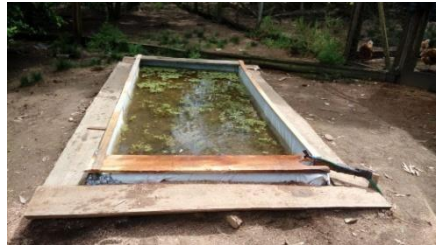
Figura 1: Piscina em fase final de elaboração. Detalhe para as tábuas de madeira protegendo a lona e para a torneira disposta em um dos cantos. Fonte: Autores
